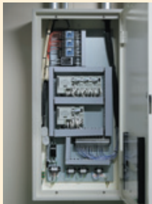
▲フロア毎の電力チェッカー、警報信号の入力T/Uを組み込んだ計量・警報ユニット盤
