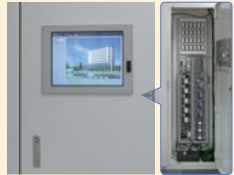
▲法科大学院1階の案内室に設置された照明主操作盤と内器
