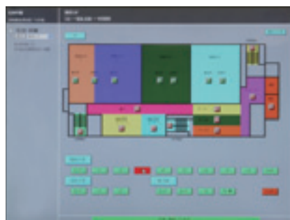
▲法科大学院1階の案内室に設置された照明主操作盤の地図画面で照明監視・制御を実施
