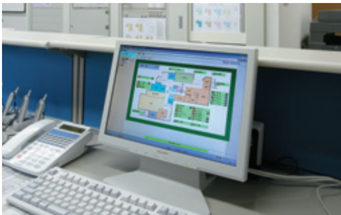
▲管理室のパソコンから館内の照明監視・制御と電力量確認が可能
