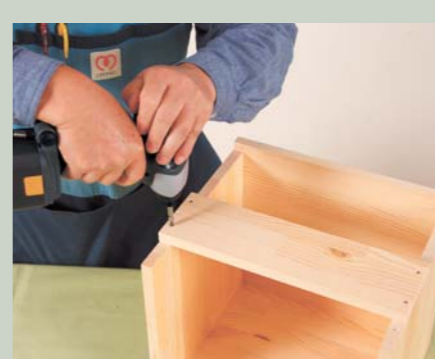
5 前板の中央部を取り付ける。
