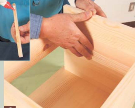
6 棚板受けの角材を木工用ボンドで接着する。
