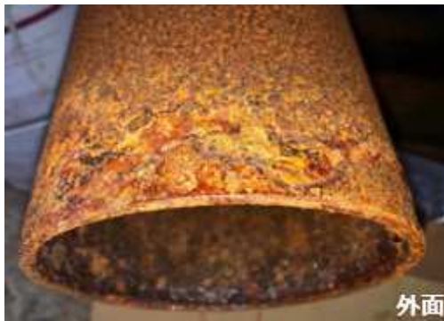
写真1 ポール外面の錆状態
