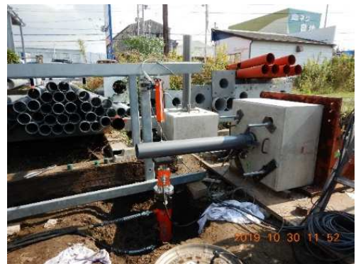
写真4 載荷試験実施状況
