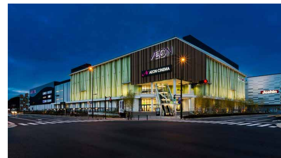
南西側より見る
