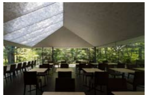
「NEZUCAFÉ」。トップライトからの光がタイベック（透湿防水シート）を透過して室内に落ちる。
