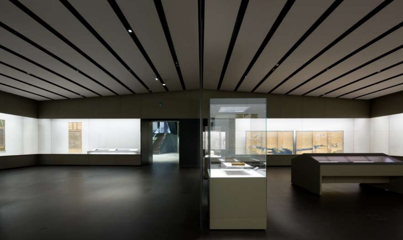
1階企画展示室。フロア内および壁面の展示ケースの照明にはLEDが用いられている。空間とのバランスから、ホールより小さな照明器具を使っている。手前展示ケースには防震装置を設置。天井は緩い勾配が左右に振り分けられ、スリットに照明および空調吹き出しを納める。床仕上げはコルクタイル。
