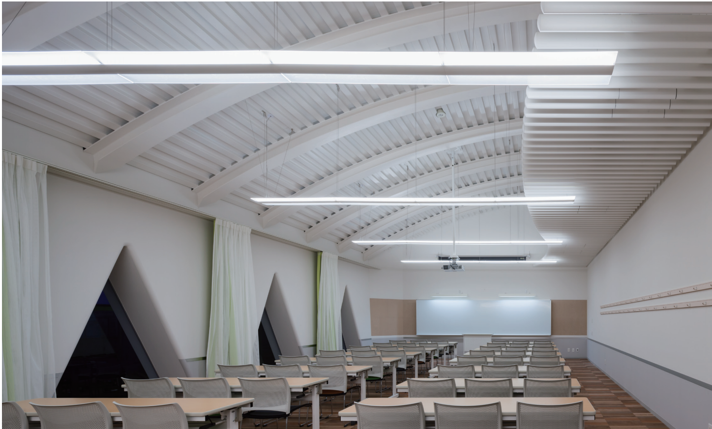
2階講義室夜景。「LEDペンダント 上下配光 導光パネルタイプ」によって、天井面と机上面の明るさを両立している。器具の取り付けピッチは3m。
