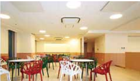
ラウンジ。乳白色パネルを付けた丸形ベースライトをランダムに配置。
