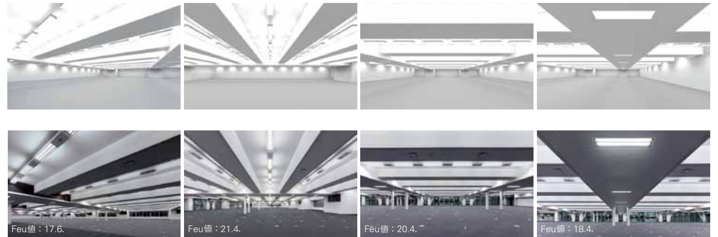
基準階執務室の照明計画シミュレーション(上)と竣工後の写真(下) ※Feu値は初期の100%点灯時、机の入っていない状態。
