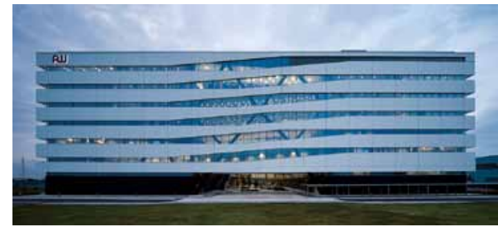
南面夕景。90m×32mの大平面からなる東西のウイングをスキップフロアとし、スロープと中間フロアで繋ぐことでコミュニケーションの活性化を図る。南面スロープ脇には打合せスペースが設けられ、人びとが集ってくるようにダウンライトがランダムに配置されている。
