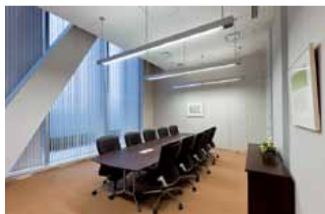
1階会議室。スキップフロアによってできた高天井の空間に、上下配光の照明器具を吊り、効果的に空間の明るさ感を向上させている。上と27頁上の写真提供：パナソニック電工
