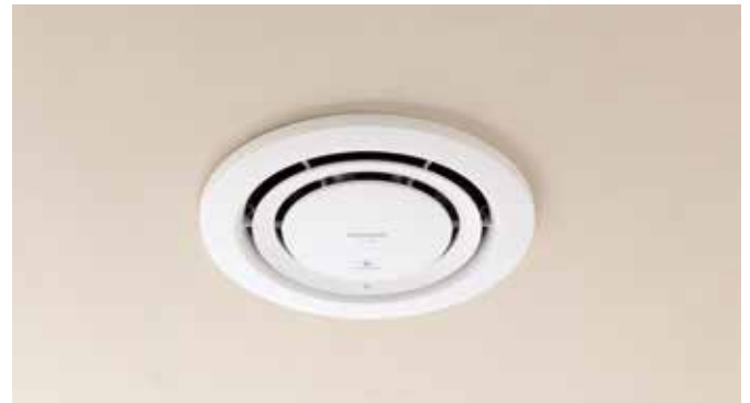
男子トイレに設置された「エアイー」。廊下においてにおいが漏れなくなったと好評。施工も簡単で、短時間で完了
