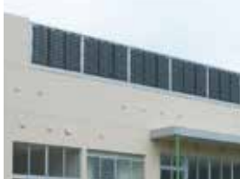
屋上フェンス
