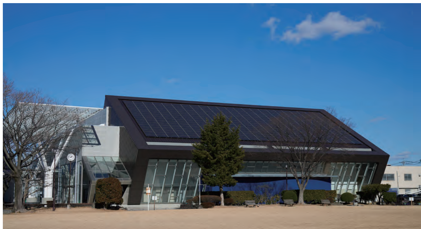
最適な発電量を考慮し、30°に合わせて設置された太陽光発電システム。
