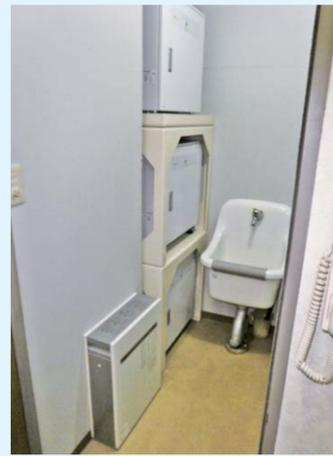
病院のBCP対策（事業継続計画）リニューアル。発電機導入のご要望に対して騒音他のリスクを考慮し、リチウムイオン蓄電池をご提案しました。補助金活用をすることでコストも抑制し、停電時対策を行いました。さらに二期工事として太陽光発電も設置し、創蓄連携システムで12時間以上の停電にも対応できる体制づくりに貢献されました。
