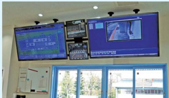
国立印刷局セキュリティリニューアル。警備棟の建替えに際してセキュリティ設備の一元管理を提案されました。メーカーをパナソニックで統一し、自火報、防犯設備、入退室管理、外周監視をLAN経由で中央監視するシステムにリニューアル。セキュリティ機能の高さだけでなく、一元化による管理のしやすさ、メンテナンス負担の軽減も評価されています。
