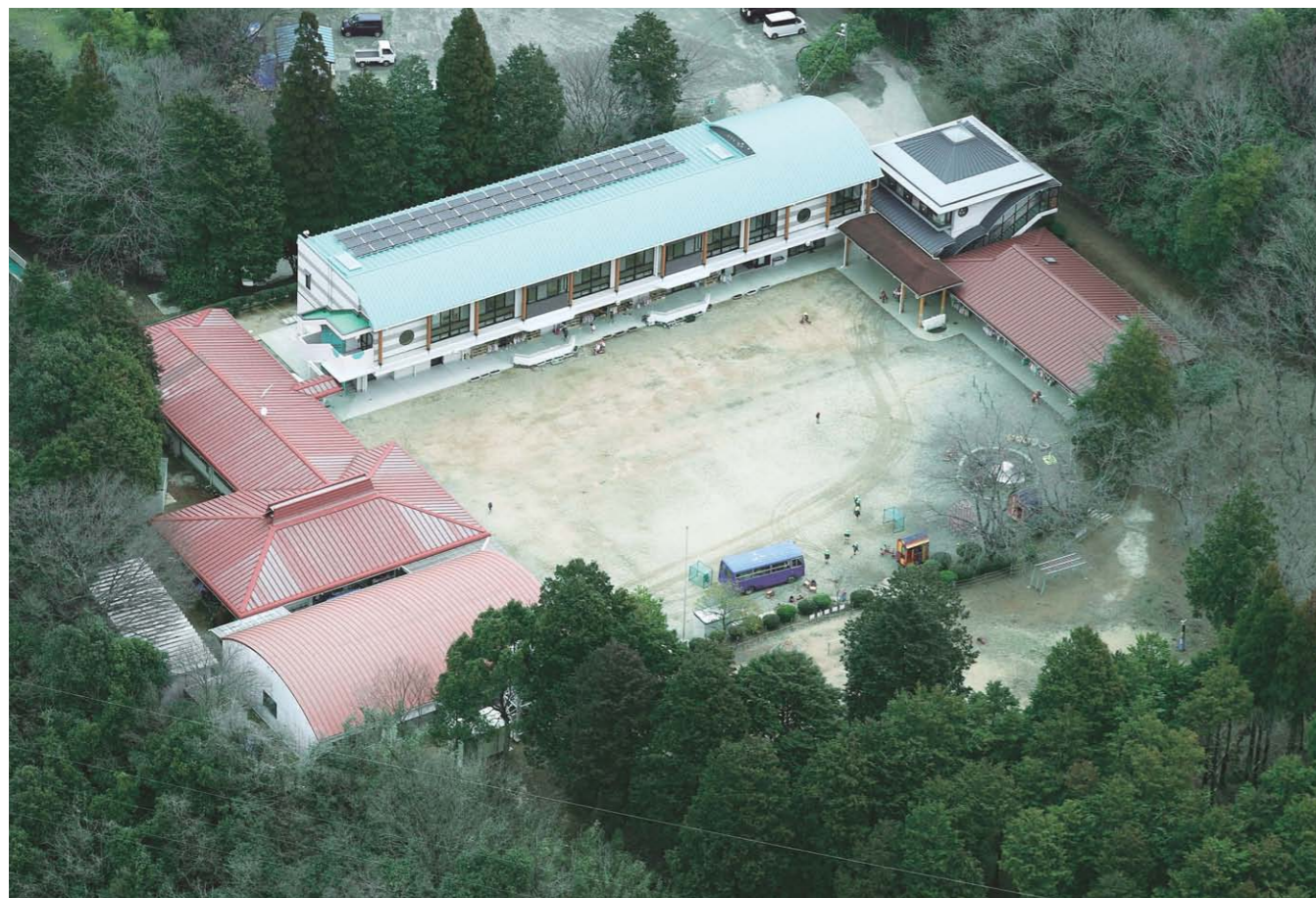
メインとなる園舎の屋上に、大規模な太陽光発電システムが設置されました。
