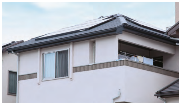
陽当たりのより南向きに設置された太陽光パネルは、曇りの日でもしっかり発電。
