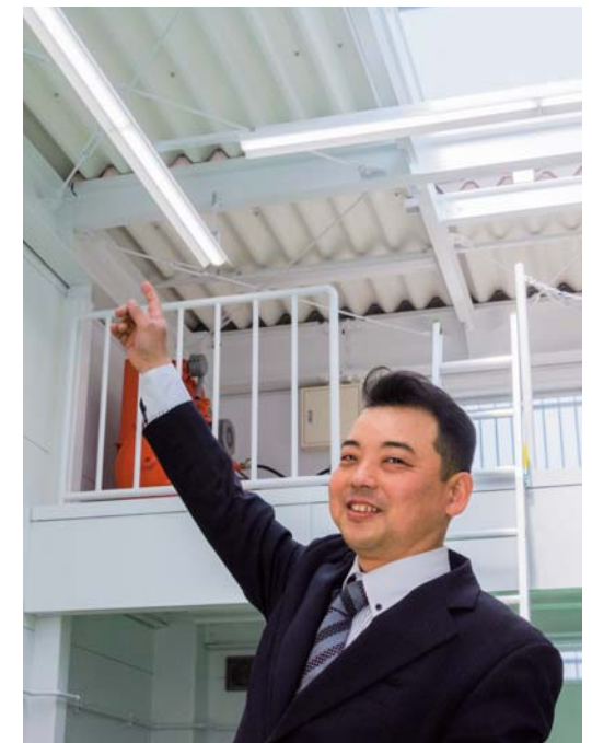
▲ 作業ビット内のLED照明器具IDシリーズと 真栄電設株式会社代表取締役 坂口 真也 様
