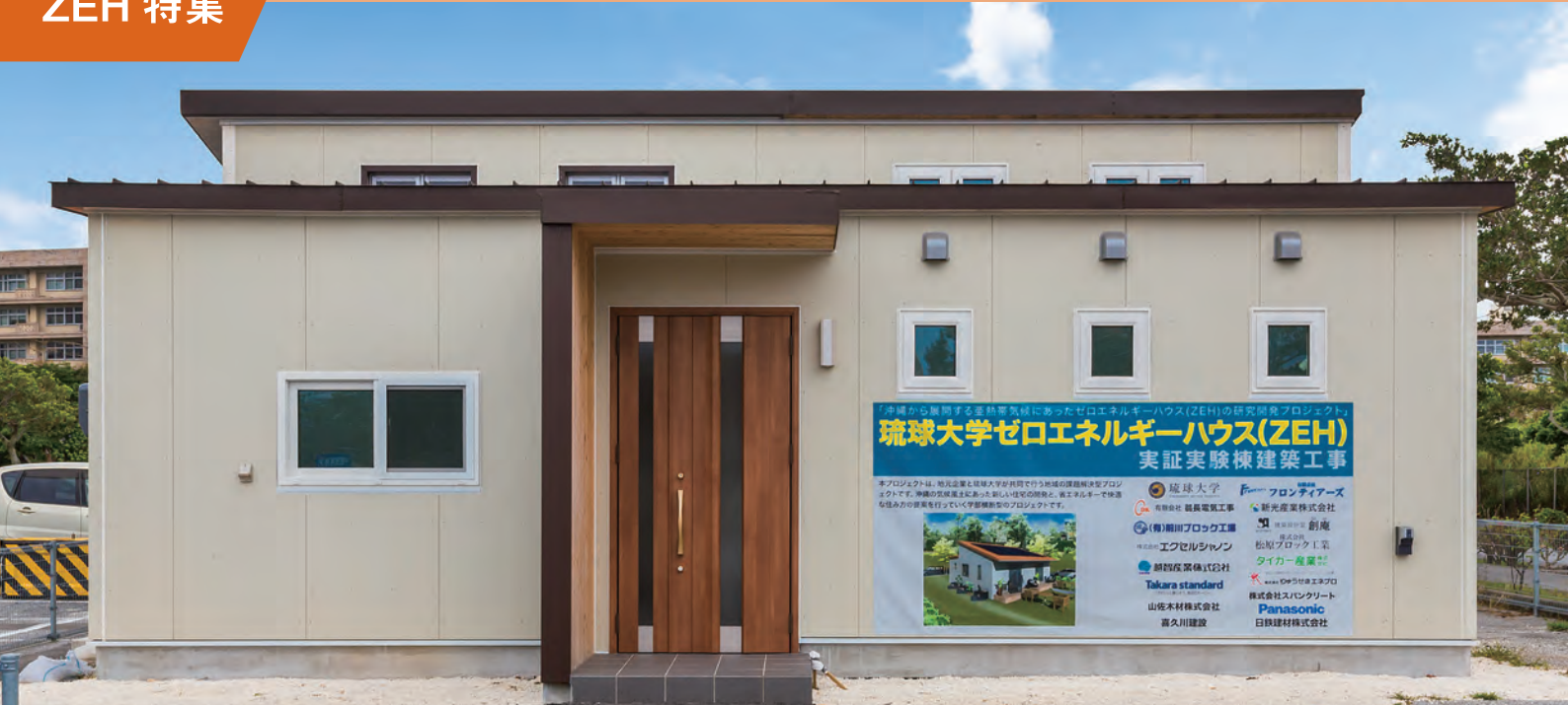
琉球大学キャンパス内に建つゼロエネルギーハウス（ZEH）実証実験棟。延床面積68.87平米の2LDKの平屋。
