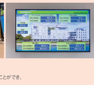
画面を切り替えさまざまな設備を 見ることができます。
