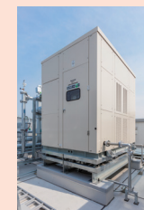
廃熱投入型吸収式冷水機
