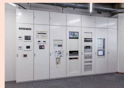
中央監視システムWeLBA。 様々なメーカーの設備を組み込むことができ、 ビルの設備を一元管理できます。
