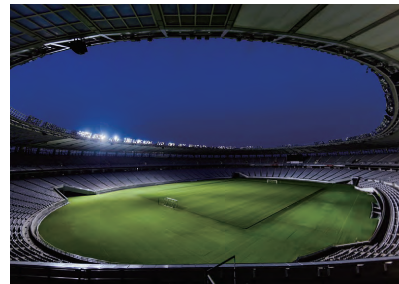
競技に合わせた照明パターンの切り替えが可能。LEDならではの瞬時点灯や0～100%のシームレスな連続調光も実現
