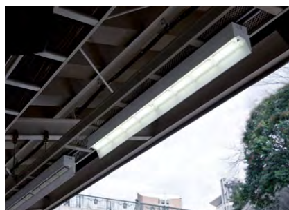
運転士へのグレアを抑える配光制御を行った LED ホーム照明器具 ④
