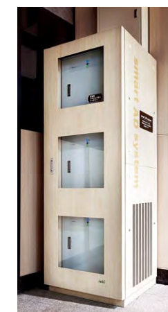
サインの使用電力を ピークシフトするための 蓄電システム (3.2kWh×3台) ②
