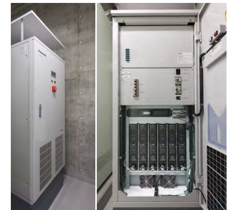
15kWhのリチウムイオン蓄電池を備えた蓄電システム
