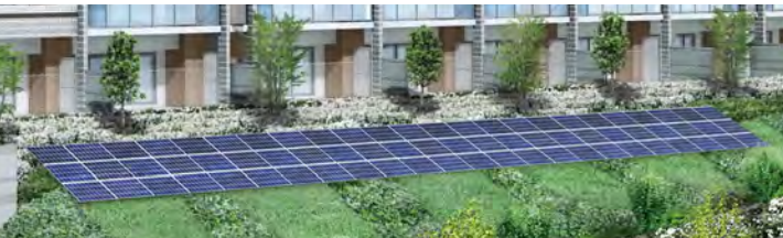
メンテナンスに配慮して南側斜面に設置された太陽電池モジュール（完成予想図） ©野村不動産株式会社
