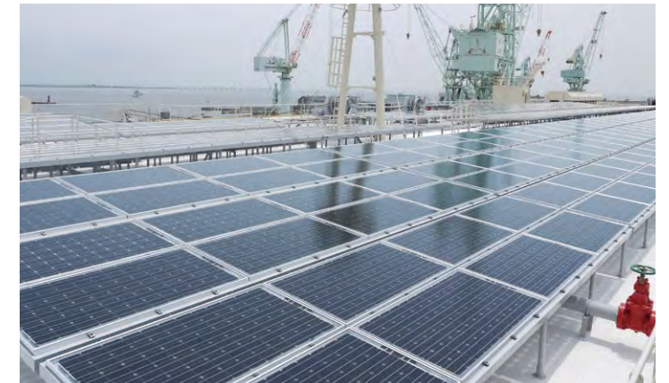
甲板に設置された160kWの太陽電池モジュールHITダブル（出力210W×768枚）
