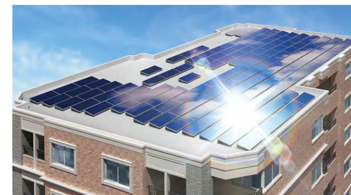
屋上に設置された太陽電池モジュール HIT233(140枚)
