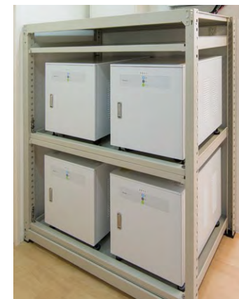
停電時に電子薬歴システムやネットワーク機器を約8時間稼働させるリチウムイオン蓄電池
