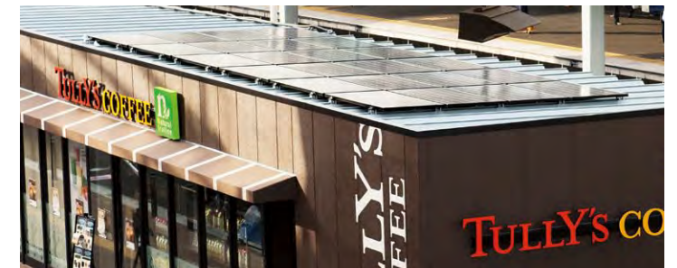
屋上に設置された10kWの太陽電池モジュール
