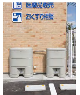
雨水を有効活用するために設置されたレインセラー
