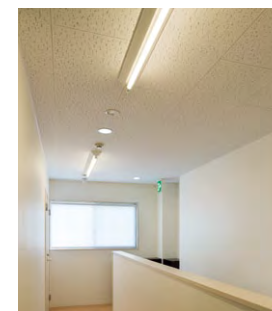
バックヤードに設置された直管LED照明器具
