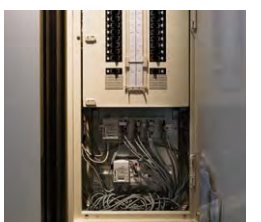
多回路エネルギーモニタが設置されている分電盤
