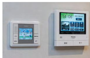
ECOマネシステムのエネルギーモニター(左)とインターホン(右)
