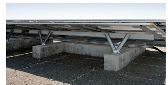
埋立地の地下から発生するガスが滞留しないように設計されたH型基礎
