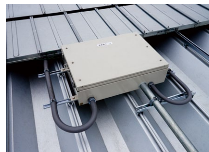
8回路の太陽電池モジュールを束ねる接続箱
