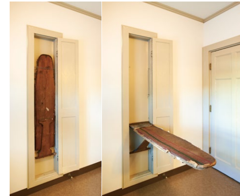
創建当初からあるアイロン台。作り付けて、台所の壁にしまう。限られた空間を効率よく使い、収納する工夫が各部屋に見られる
