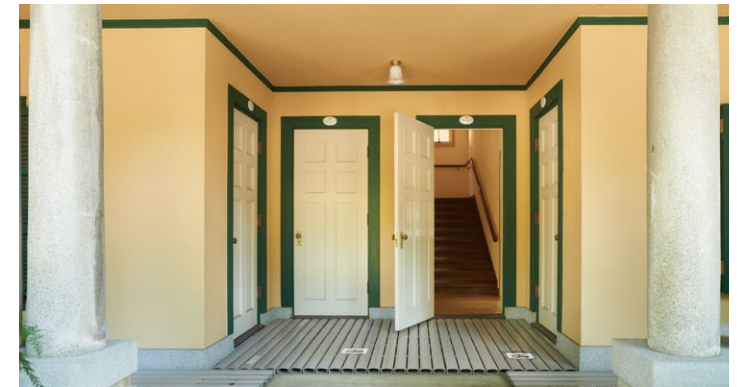
玄関ポーチは4戸の共有。2階の住戸は階段を上った所に居間につながるドアがあった。階段用のスペースは壁で二分されていたため、創建当初の階段は現状よりも急勾配であった
