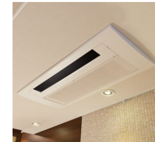
LDKの天井カセットタイプエアコン
