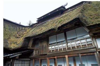
後年、2階を増築したため、採光のために屋根を切り上げである。他の曲り家には余り見られない珍しい造り
