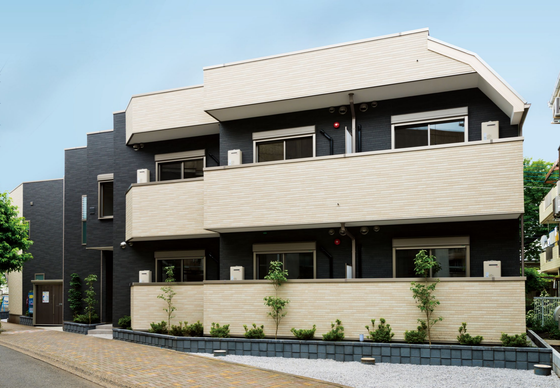
テクノストラクチャー工法により変形敷地を有効活用した賃貸アパート
