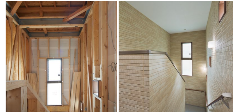
階段吹き抜け部のテクノビーム(工事中)
