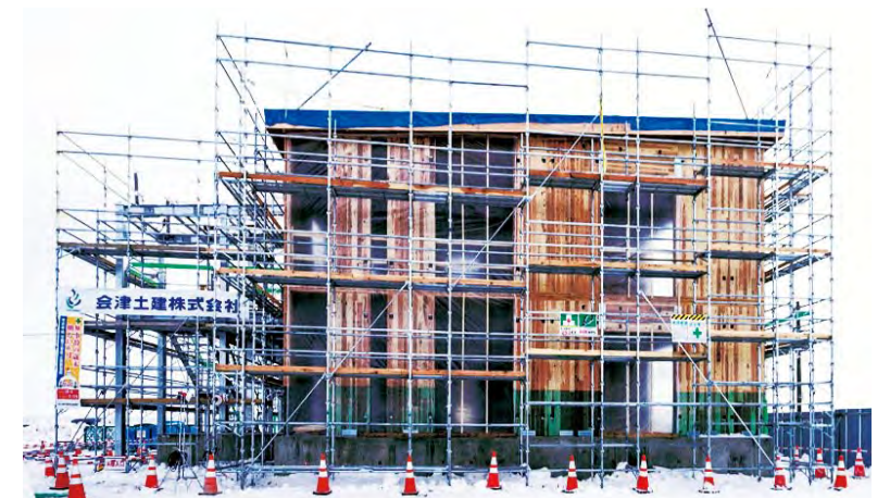
建設中のCLT建築
