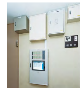
村役場の照明制御盤、電力計測器
