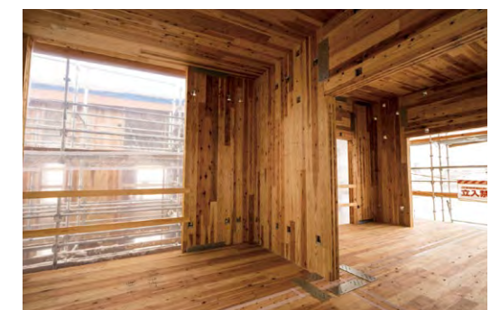
CLTパネルは構造材としての機能も発揮する
