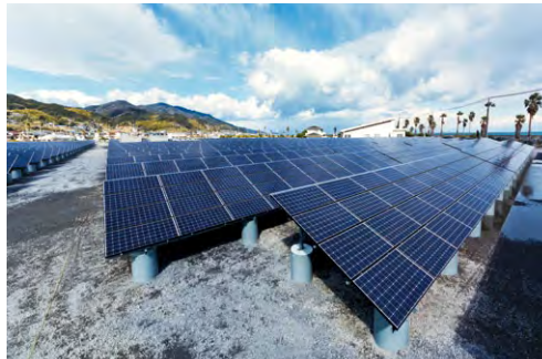
発電効率を考え、アレイ方位角0度・傾斜角20度に設置された太陽電池モジュール
