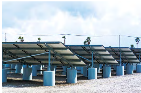
筒状の型枠鉄板を化粧板として用い、コストを抑えた基礎
