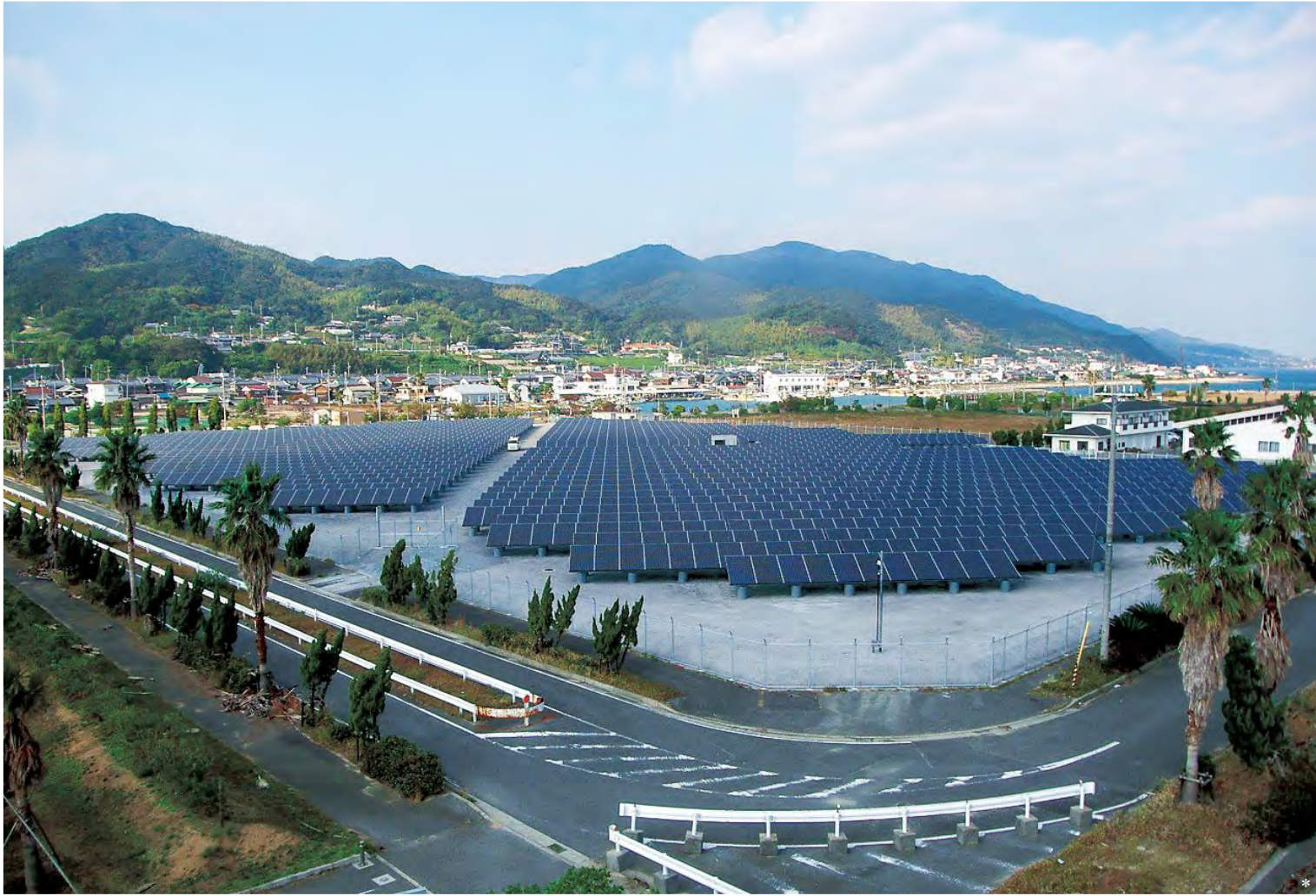
南東方向に向けた土地に効率的に配置された太陽電池モジュール「HIT」
