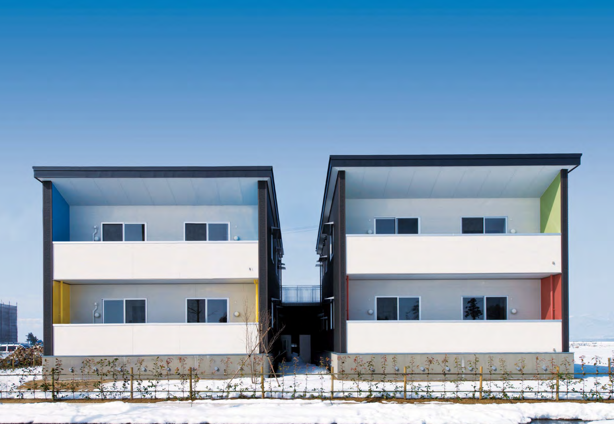
断熱性能を比較するため、外張り断熱(左棟)と内張り断熱(右棟)で建てられた東日本初のCLT共同住宅
