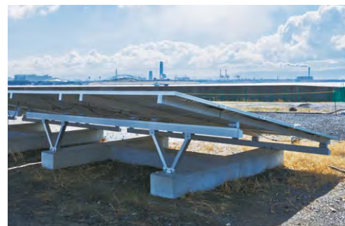
埋立地の局所沈下に対応する地盤掘削が不要なH型基礎
