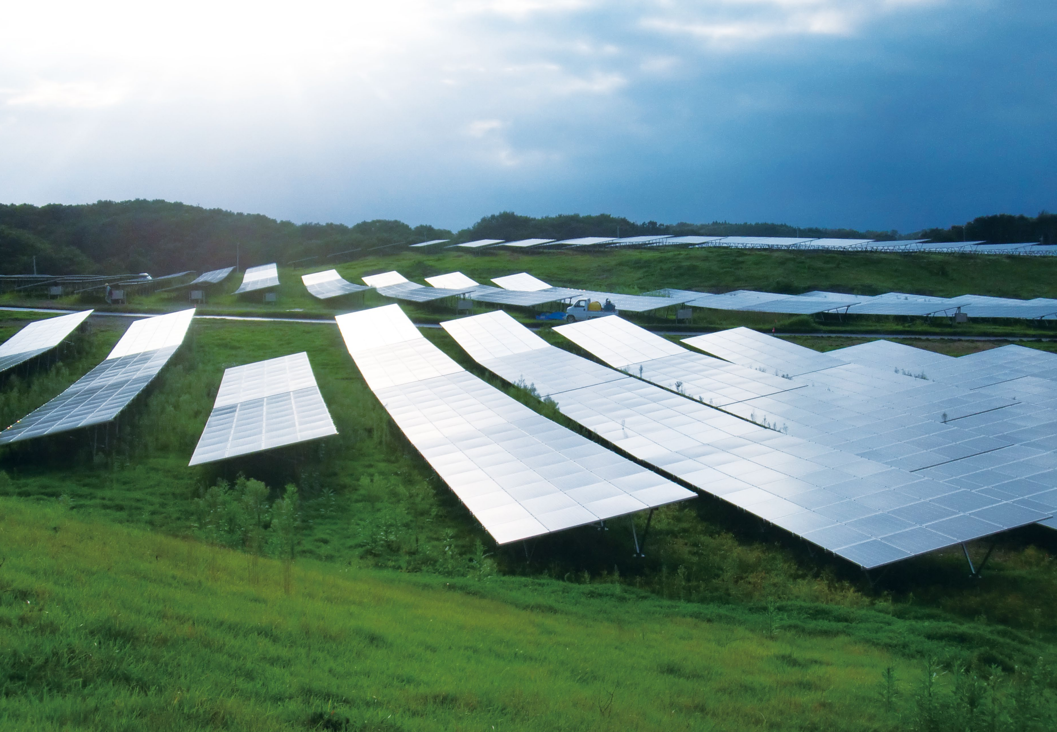
約38haにもおよぶゴルフ場のコースに配置された、63,000枚の太陽電池モジュール
