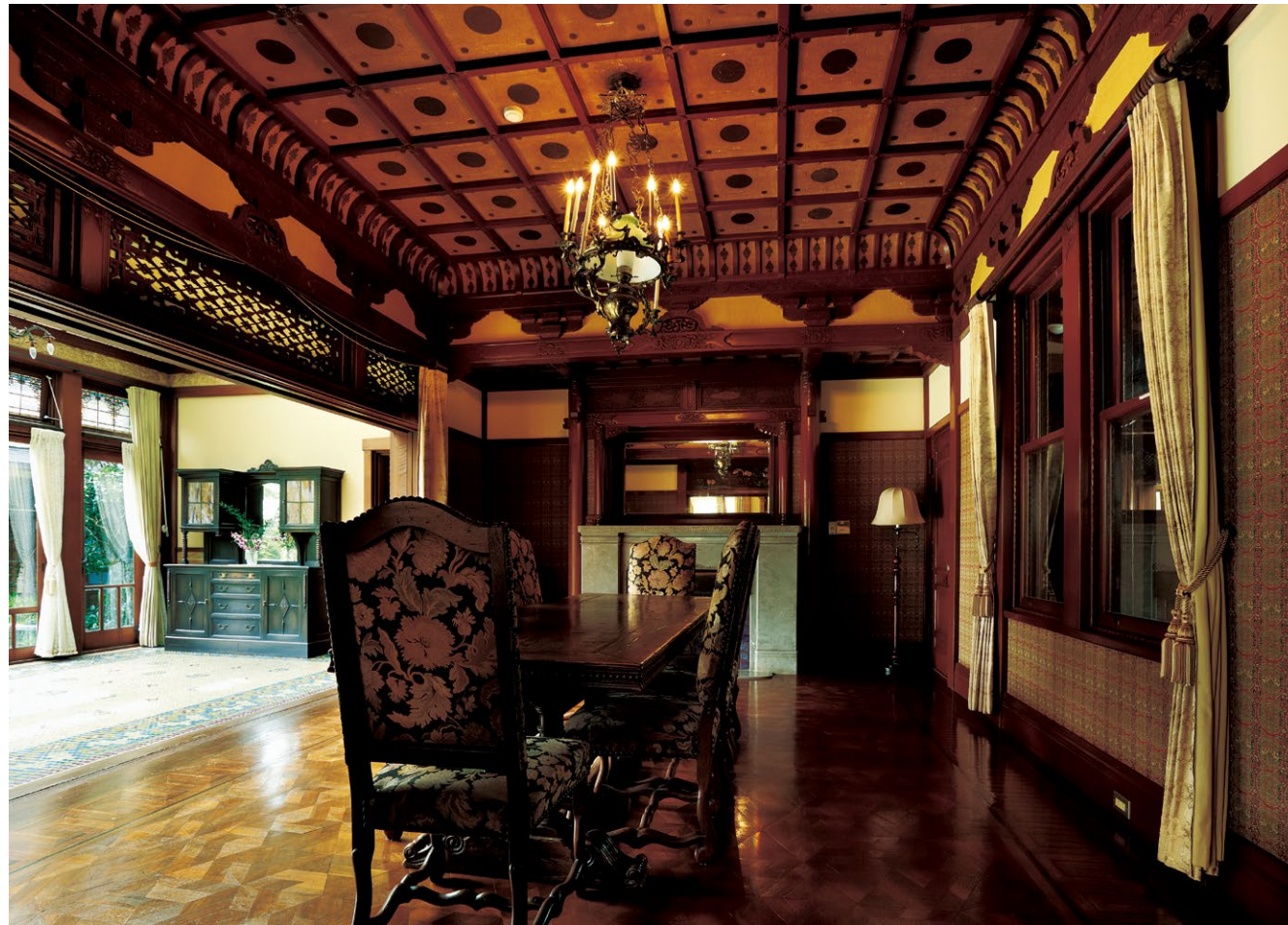
根津嘉一郎が増築した「玉姫」。寄せ木張りの床に暖炉を置く洋間だが、折上格天井、かえる股、斗拱（ときょう）など、社寺建築に多用される工法・装飾が共存する
