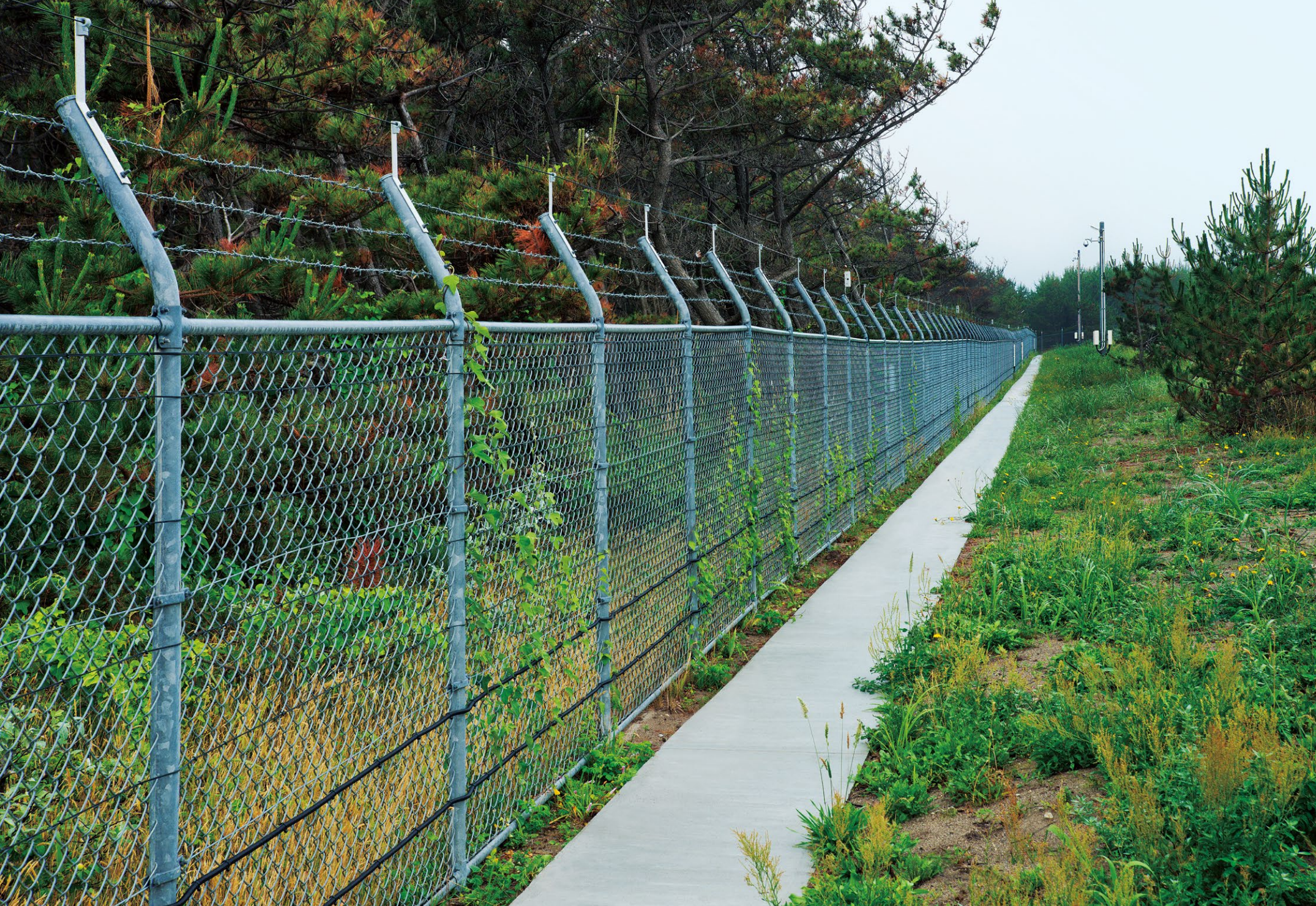
フェンスに装備された光テンションセンサと断線センサ。侵入を感じし、ドームカメラが連動して該当箇所の映像を守衛室に送る
