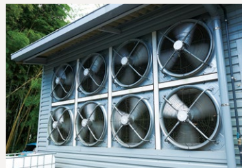
牛舎長手面に設置した給気用スマートファン
