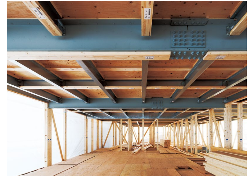
リビングルームの梁に採用された「剛接合対応」のグランドテクノビーム
