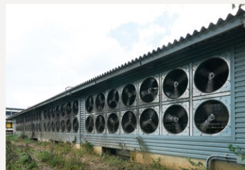
壁一面に設置された排気用スマートファン
