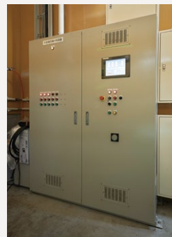
タッチパネル操作の制御盤
