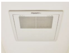
熱気調システムの 屋内側空気取入口
