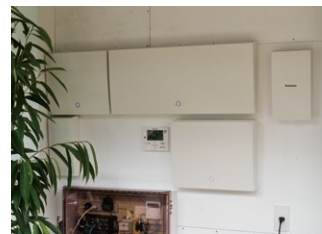
ピロティの住宅用分電盤スマートコスモ
