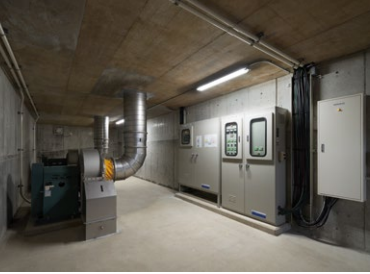
堆肥舎施設で発生するアンモニアなどを含んだ空気を脱臭ロックウール槽に送るポンプ施設
