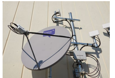
万一、光回線が断線した場合も通信機能を維持するための衛星インターネット設備
