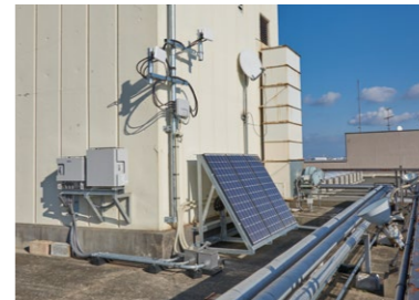
卸町会館に設置された通信装置。停電対策として太陽光発電とリチウムイオン蓄電池を備える
