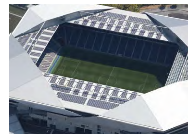
屋根3カ所に設置された太陽電池モジュール 2,100枚で約500kWを発電
