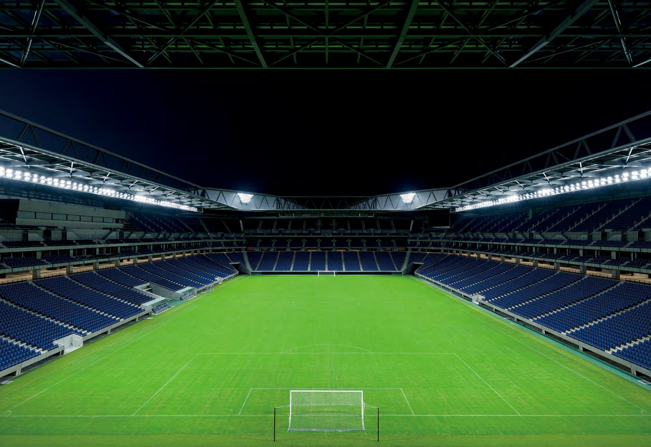
中角・広角配光の投光器を分散配置することで、見上げた際のグレアを軽減
