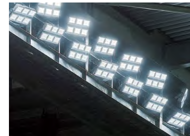
両サイドのキャットウォークに配置された モジュールタイプLED投光器
