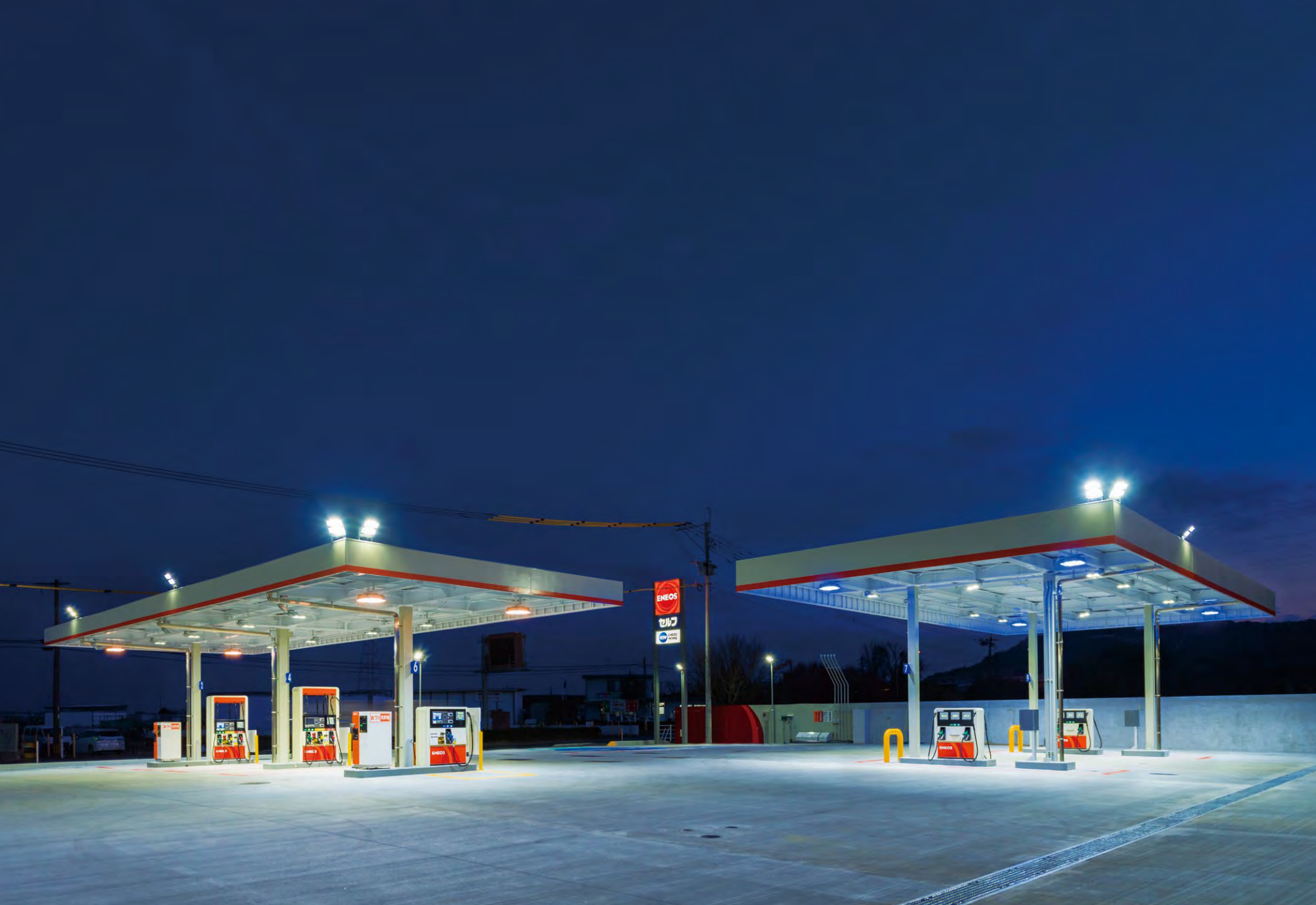
水銀灯と同等の照度を確保するLED投光器に全面リニューアルした植木インターTS
