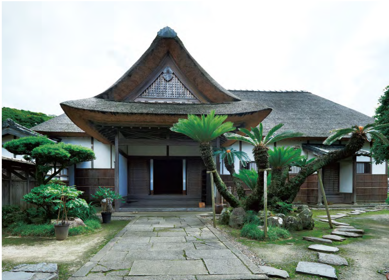
上級武士の屋敷らしい威風堂々たる表構え。主屋の屋根には阿蘇山麓の茅が約4,000束(1束の直径は約30cm)も使用されている。
