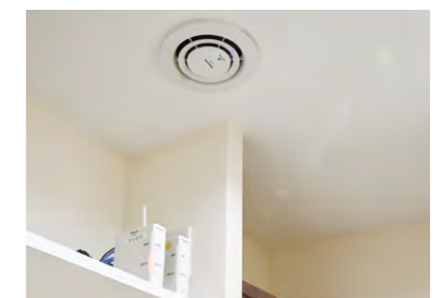
クローゼットのAISEGとアドバンス用無線アダプタ天井にはエアイーが設置されている
