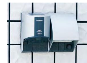
EV充電用屋外コンセント（左）
