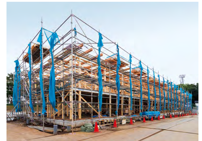
テクノストラクチャー工法で建設中の学生寮(B棟)
