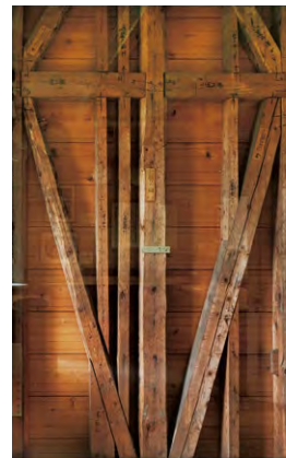
中央棟1階の軸組。多くの筋交いを入れて補強しているのが分かる。
