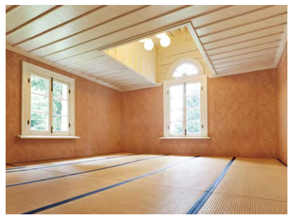
付属棟2階の畳部屋。窓のデザインを生かすために天井の形が工夫されている。
