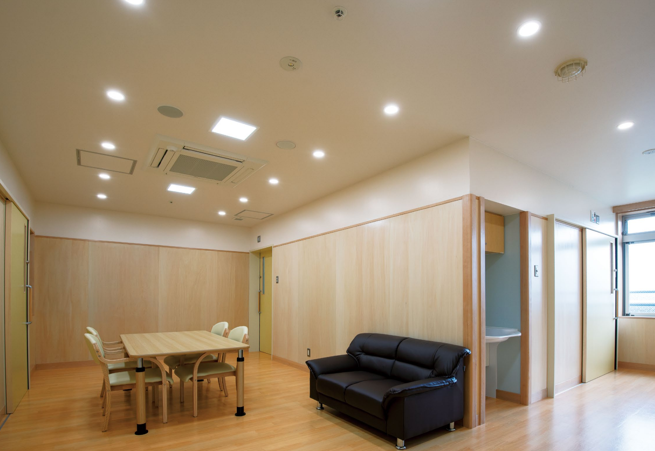
3つの居室に面して設けられたデイルームではスクエアタイプのベースライトに加え、器具の存在感や眩しさを抑えた「スマートアーキ ソフトライト」が採用されている
