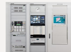
非常放送設備、監視カメラ設備、照明制御盤(左から)
