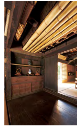
①「といのま」。竹樋の上が2棟の茅葺き屋根の谷。②南側*に付き出した樋。③樋に傾斜を付け、北側*で雨水を排水。
