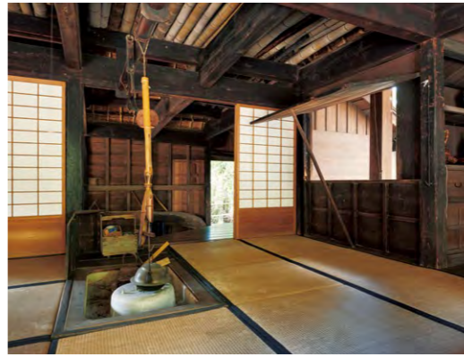
囲炉裏のある「なかえ」は家族の生活の場。2棟がずれて建っているのを利用して、東面*に風通し用の部戸を設けている。
