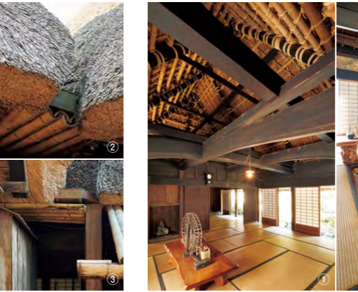
①「といのま」。竹樋の上が2棟の茅葺き屋根の谷。②南側*に付き出した樋。③樋に傾斜を付け、北側*で雨水を排水。
