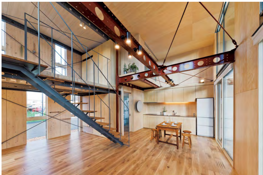
新設高断熱壁に囲まれた2層吹き抜けのリビングと既存低断熱壁のロジア(右空間)
