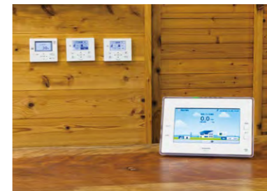
太陽光発電量が確認できる管理棟のAiSEG2
