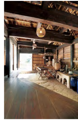
「うすにわ」。板の間に斜めに作ったのは土間を広く取る工夫。
