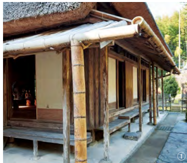
①「おもて」の東、南面には竹葺きの庇が付く。孟宗竹を2つ割りにして節を取って並べ、その上から竹を被せている。②庇の裏から見た竹の樋と木の樋受け。
