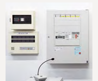
P型1級受信機(右)と業務放送設備
