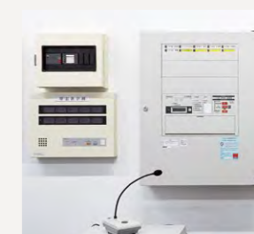
P型1級受信機(右)と業務放送設備
