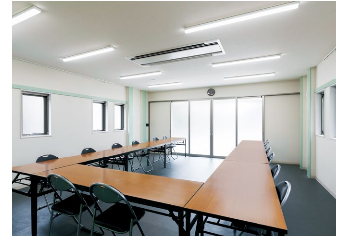
木造でありながら広い開口部を実現した「Mフレーム」（入口のグリーン柱部）
