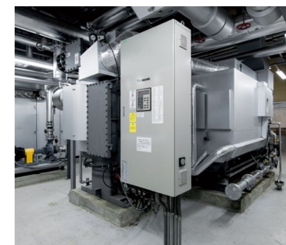
種市庁舎の高効率吸収式冷温水機
