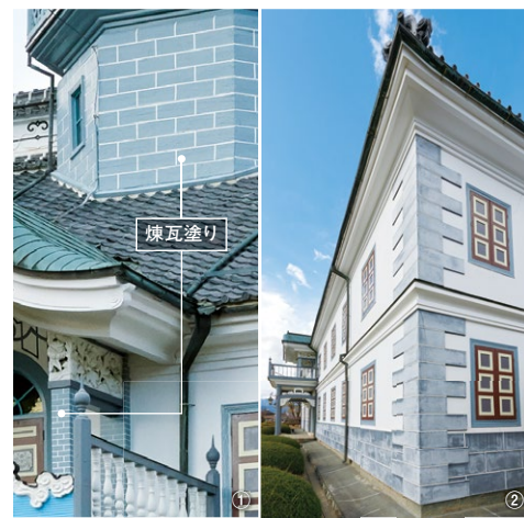
①塔屋欄干下の壁や唐破風の支柱は煉瓦造りに見えるがペンキで描いたもの(煉瓦塗り)。②隅石も石ではなく漆喰。
