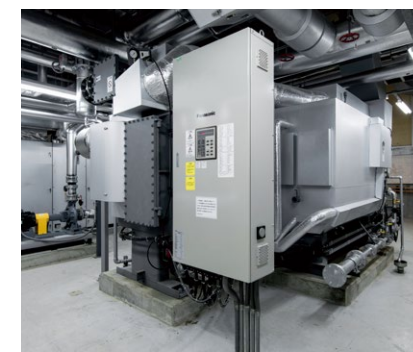
種市庁舎の高効率吸収式冷温水機
