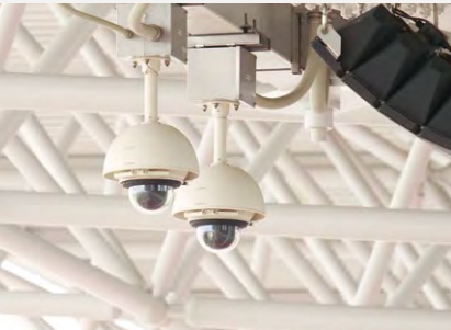
スタンド軒下に設置された 4K/HDインテグレートッドカメラ
