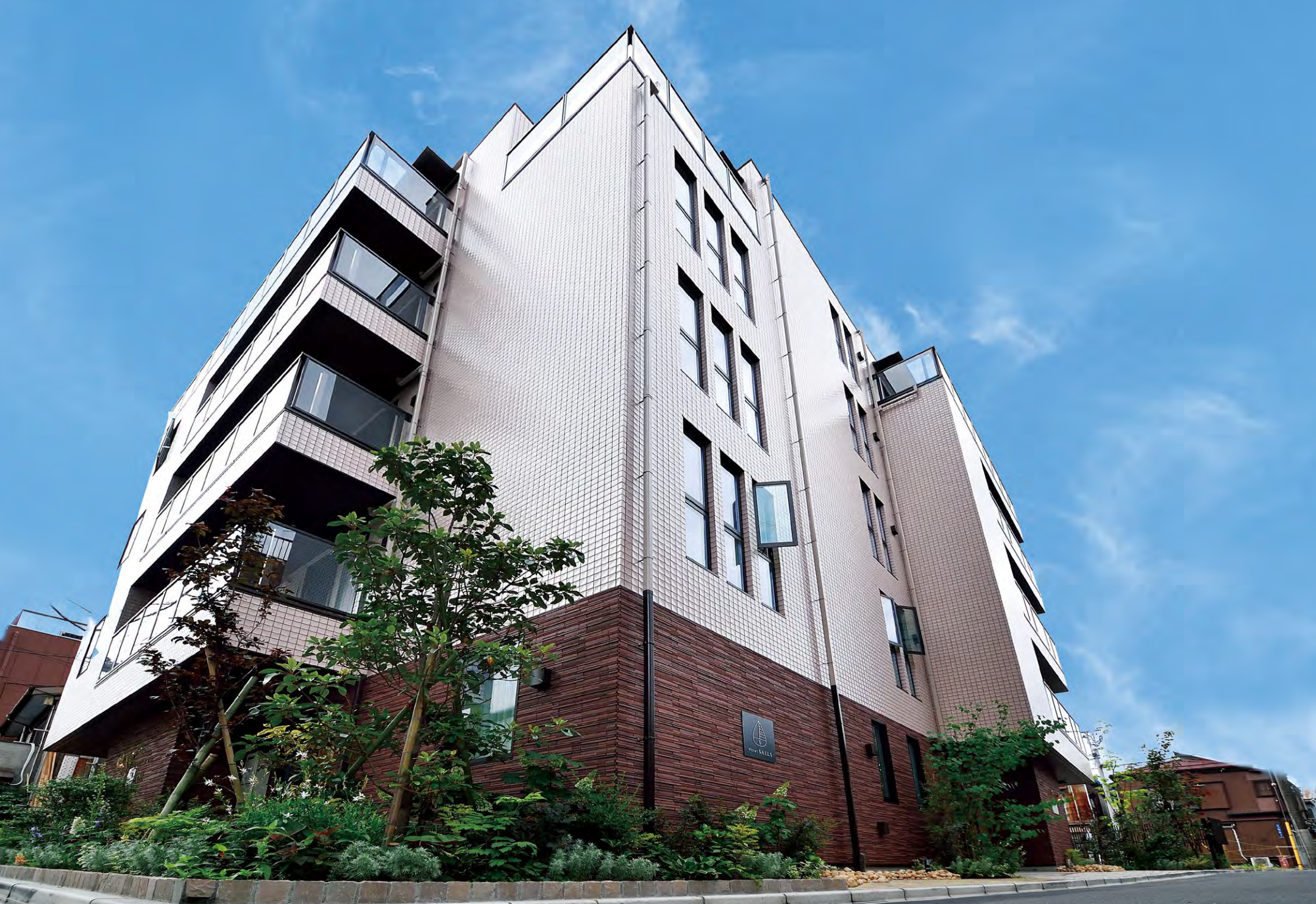
外壁には、汚れても雨で洗い流す光触媒タイル「キラテック」を採用。外壁塗り替えに伴う業務コスト軽減を図り、常に美観を保つ
