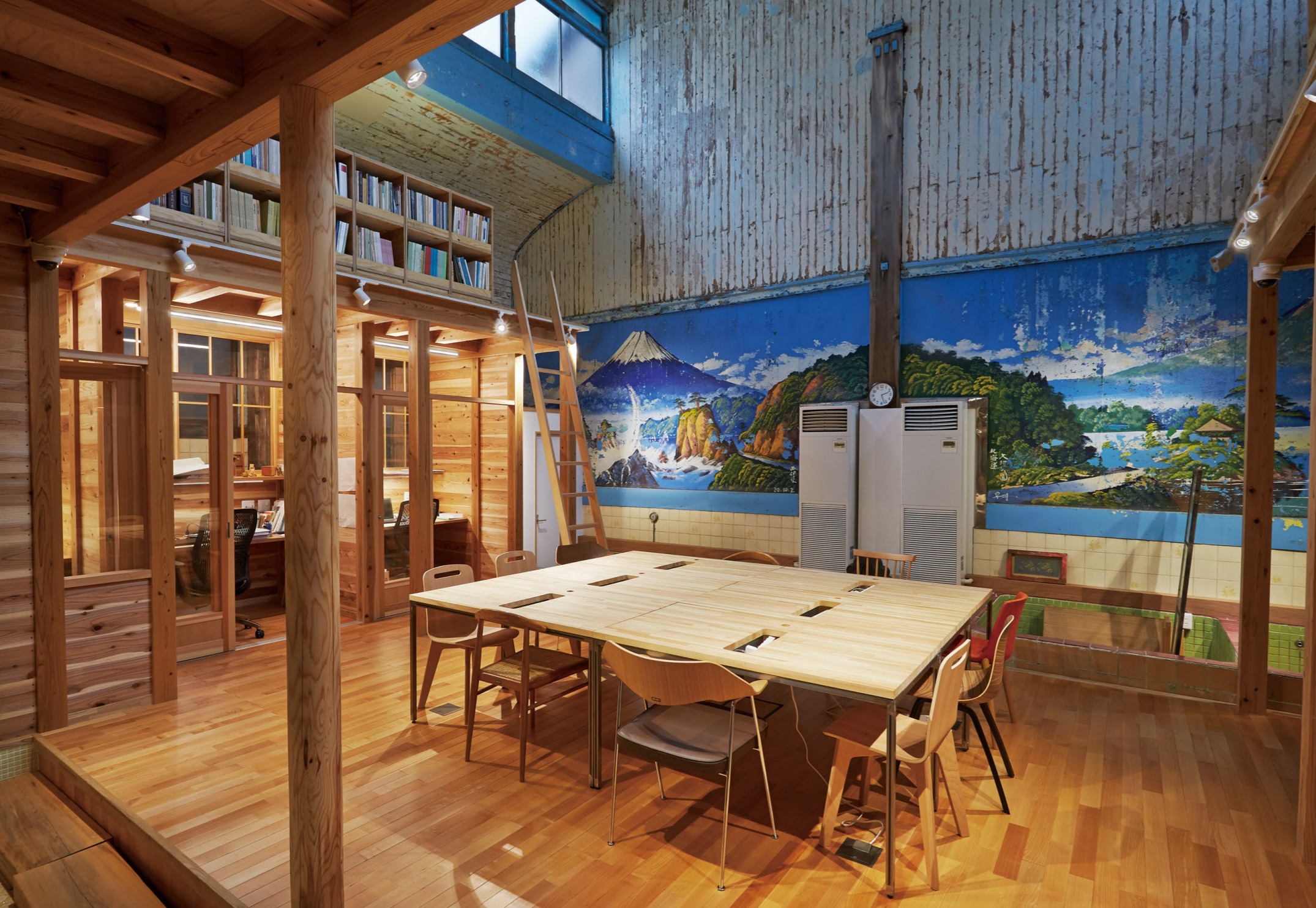
男女浴室の隔壁を取り除き、周囲にオフィスブースを設けることで耐震構造とし、中央部はレンタルスペースとしている
