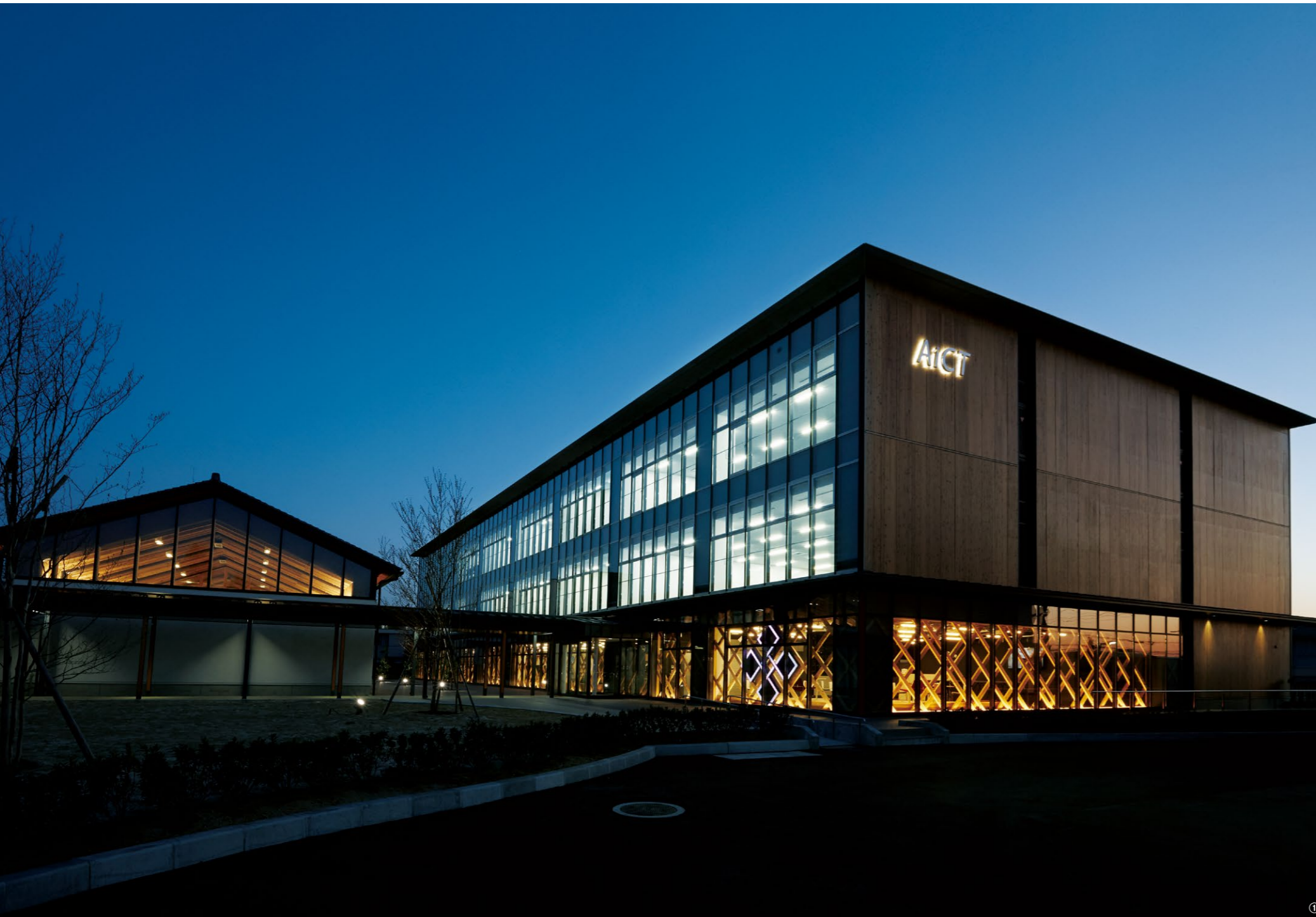
①交流棟(左)と渡り廊下で繋がるオフィス棟(右)。1階のカーテンウォール部では木格子により緩やかな視線制御を行っている
