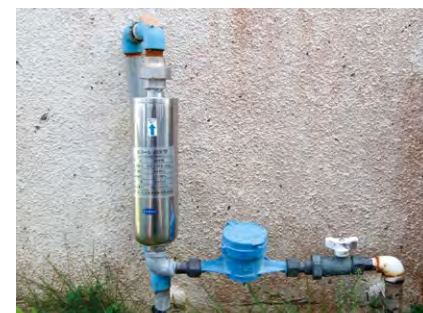
メーカーと協力して宮古島特有のカルシウム結晶化によるエコキュートのパイプ目詰まりを防ぐ軟水器
