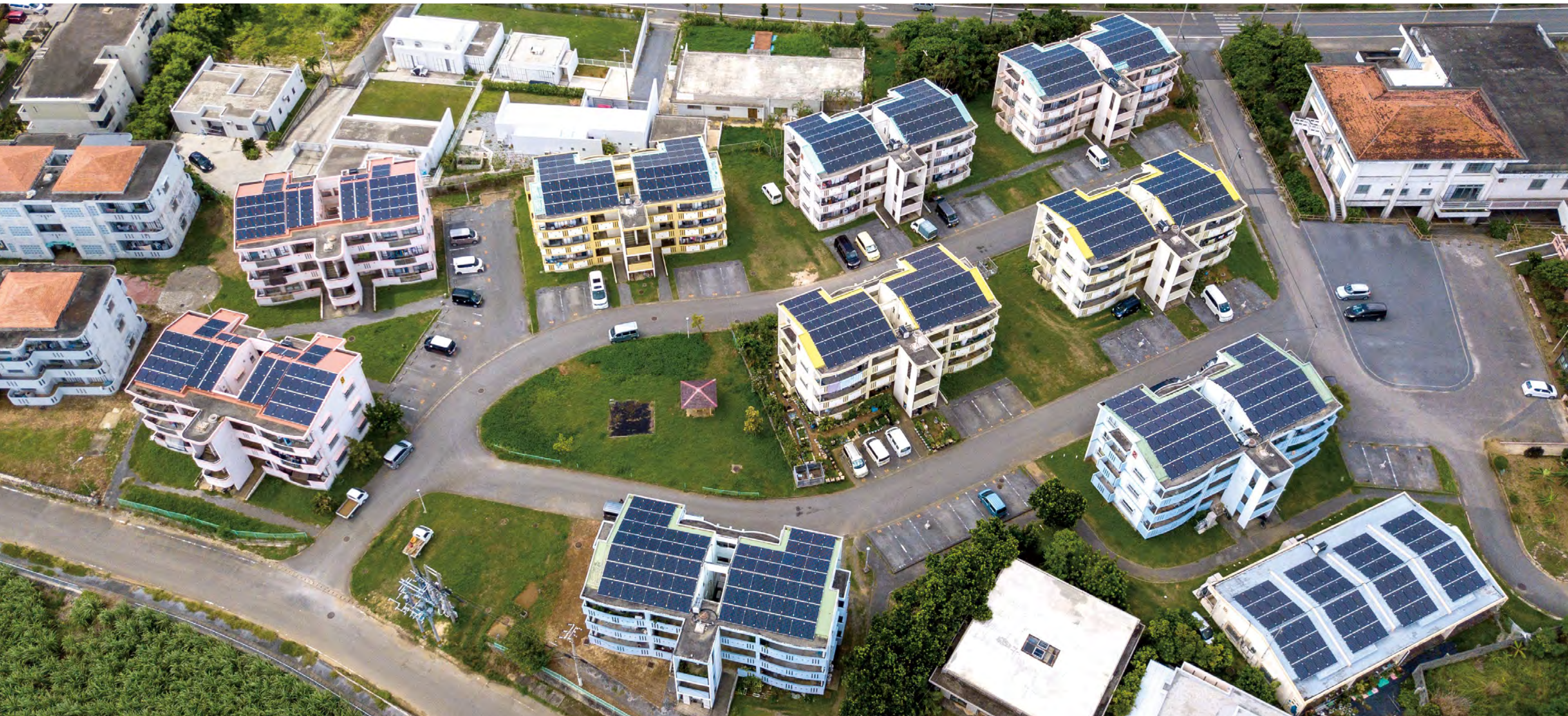
株式会社宮古島未来エネルギーが太陽電池モジュールとエコキュートなどを無料で設置し（事業者所有設備）、発電した電気を住宅に販売する下地上市営住宅10棟
